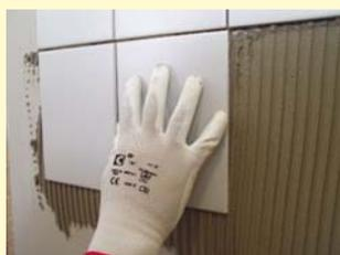
Po osazení dlaždice do tmelu vytlačíme vzduch. Spárovací tmel aplikujeme po 24 hod.
