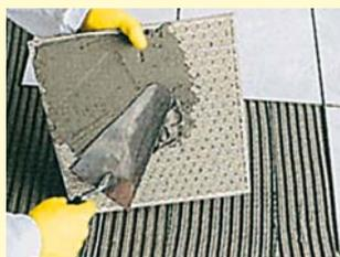
Větší rozměry dlaždic doporučujeme lepit způsobem oboustranného lepení – tzn.: Na dlaždici se nanese vrstva tmelu 1–2 mm silná. U soklů doporučujeme maximální velikost dlaždic 15 × 10 cm, lepení stejnou metodou.
