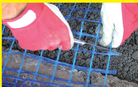
4. jednoduše zkracujeme ulamovacím nožem
