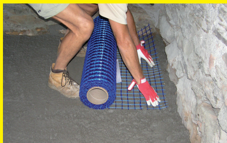
2. armovací síť vkládáme cca v 1/3 horní vrstvy potěru
