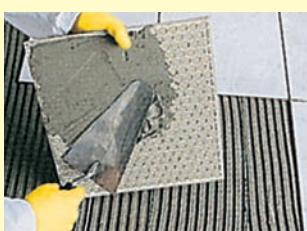
Dlaždice doporučujeme lepit způsobem oboustranného lepení – tzn.: Na dlaždici se nanese vrstva lepidla 1–2 mm silná.
