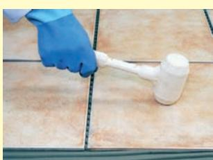
Po osazení dlaždice do lepidla poklepelem plastovou paličkou stabilizujeme dlažbu a vytlačíme vzduch. Spárovací maltu aplikujeme po 24 hod.
